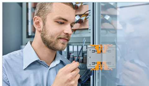
Câblage et configuration rapides
